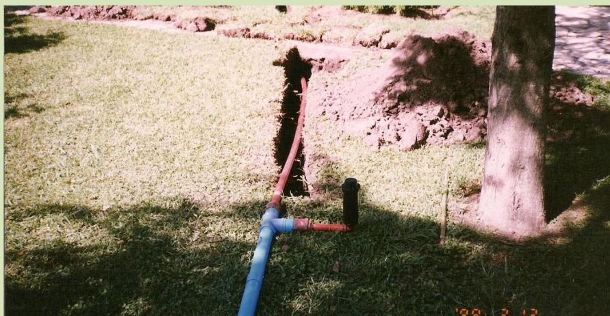
Proceso de armado de toberas emergentes
